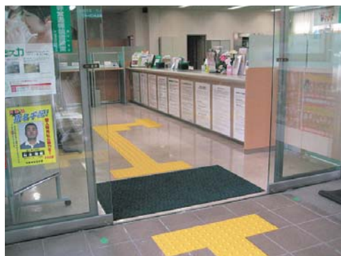
視覚障がい者誘導用ブロック（安来支店）
