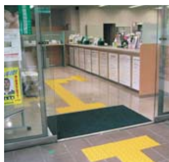
視覚障がい者誘導用ブロック(安来支店)
